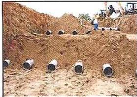
Les travaux de réalisation de cet ouvrage ont nécessité la création de deux importantes tranchées de 60 mètres de long sur 10 mètres de large et 4 mètres de profondeur, destinées à recevoir les canalisations enterrées constitutives du puits.
